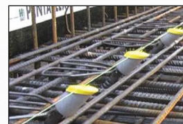
Aussparungen mit Richtschnur nivelliert
