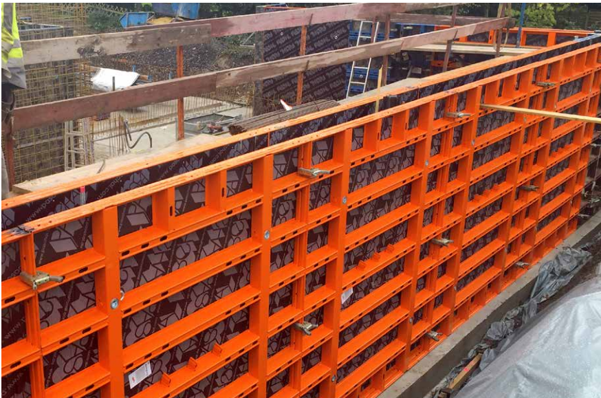
Im Elementrahmen bündig eingebaute Verspanneinheit
