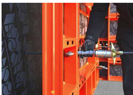
Beim einseitigen Anker wird der Spannstab zusammen mit dem Hüllrohr, der Wechselhülse und der Kugelgelenkplatte in die Verspanneinheit in der Stellschalung eingedreht.
