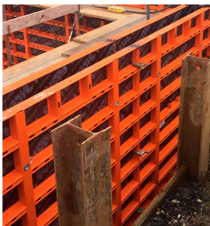
Durch die drehbare Lagerung der Spannmutter in der Verspanneinheit sind Schalungsversätze möglich.
