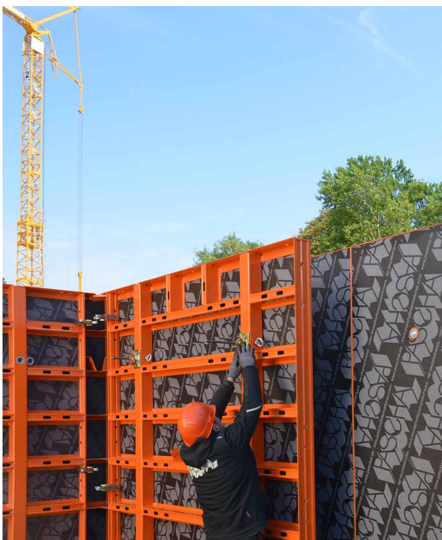
Wechselhülse und Verspanneinheit
