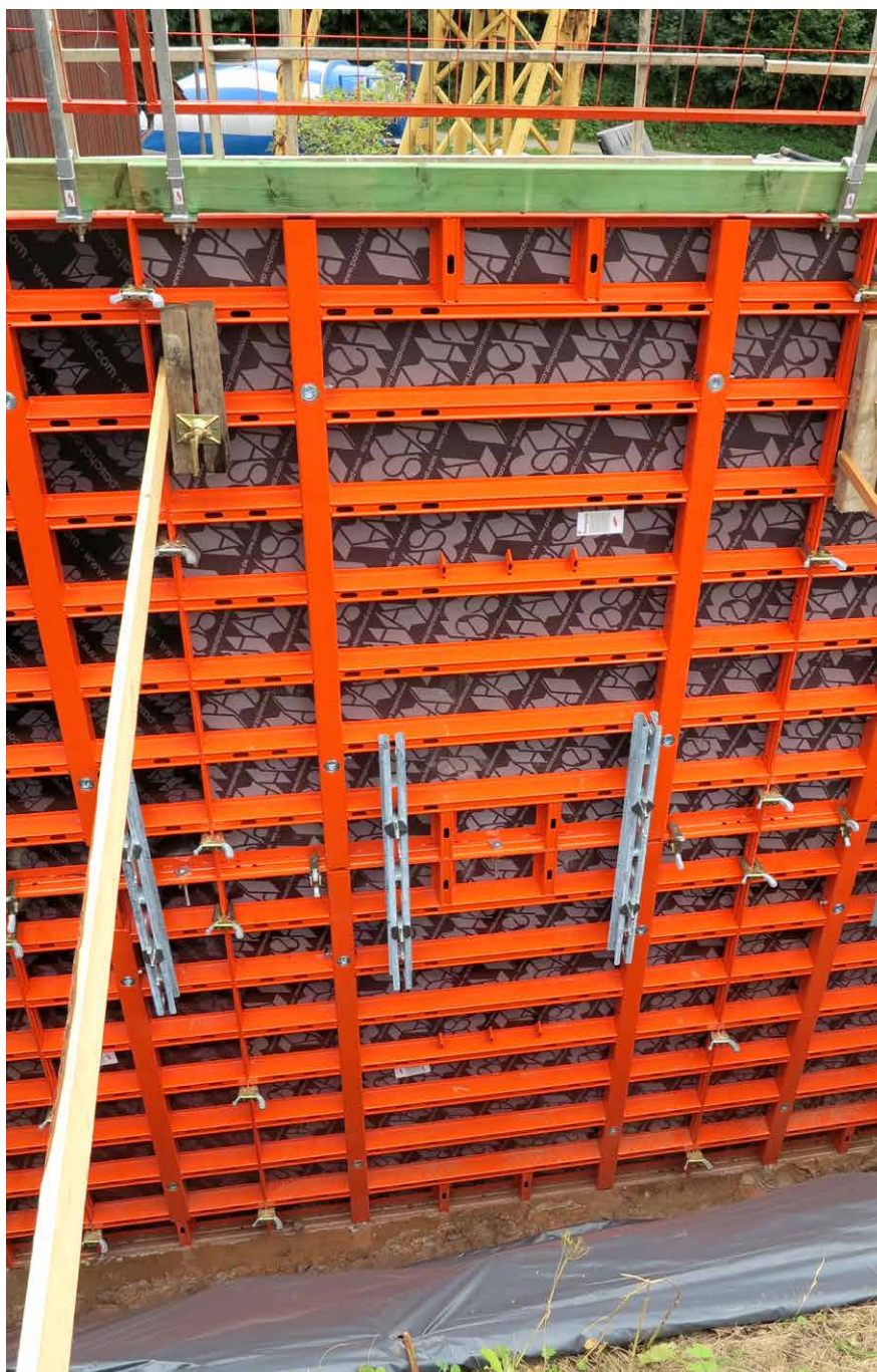
Beim einseitigen Anker wird der Spannstab zusammen mit dem Hüllrohr, der Wechselhülse und der Kugelgelenkplatte in die Verspanneinheit in der Stellschalung eingedreht.
