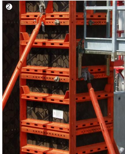
Als universelles Verbindungsmittel erfüllt die Spannschraube verschiedenste Funktionen innerhalb einer kompletten Schalung:
