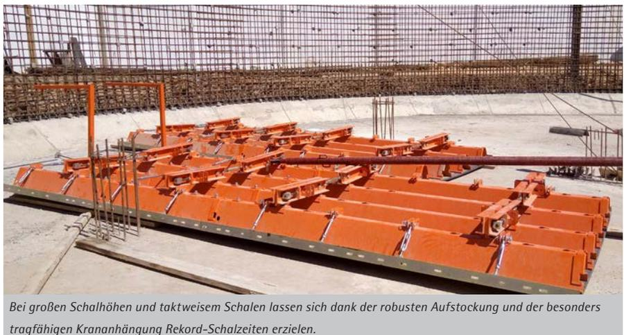
Bei großen Schalhöhen und taktweisem Schalen lassen sich dank der robusten Aufstockung und der besonders tragfähigen Krananhängung Rekord-Schalzeiten erzielen.
