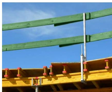
*Die Klemme Seitenschutz eignet sich mit einer Klemmbreite von bis zu 60 cm besonders gut für den Einsatz an Deckenschalungen.*
