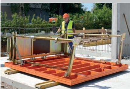
Nach der Vormontage bzw. dem Aufklappen der Beläge wird die Schalung zusammen mit den Bühnen und Abstützungen gestellt.
