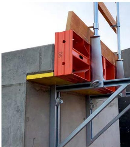
Zum Betonieren von Konsolen kann der Anschlag um 50 cm verschoben werden.
