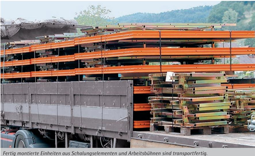
Fertig montierte Einheiten aus Schalungselementen und Arbeitsbühnen sind transportfertig.
