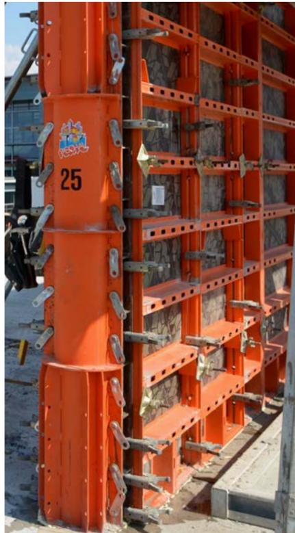
Halbrunder Abschluss einer Wand, hergestellt durch Verbindung von Rundstützen-Halbschalen mit der LOGO.3 Schalung.
