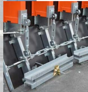
Das Foto zeigt die verstellbaren Voutenträger. Sie sind mit den Trapezträgern verschraubt. Wichtig: Die Auftriebssicherung am Fuß der Voutenträger. Fachgerechtes Verdübeln auf der Bodenplatte ist unerlässlich!
