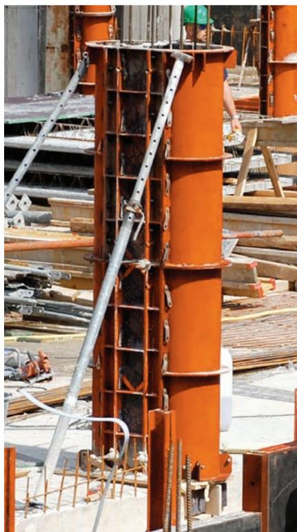
Bei diesen Ovalstützen wurden spezielle Elemente mit Stahlschalhaut direkt mit den Halbschalen der Rundstützenschalung verbunden.
