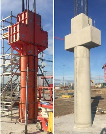
Spezielle objektbezogene Schalungen für Bauteile, bei denen der Einsatz von Systemschalungen nicht oder nur bedingt möglich ist
