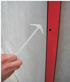
3 Drehen & Ziehen des FLUXX-Ankers zur Arretierung der FLUXX-Schiene
