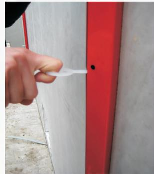
**Achtung!** Vor dem Betonieren den festen und korrekten Sitz der Schiene überprüfen!
