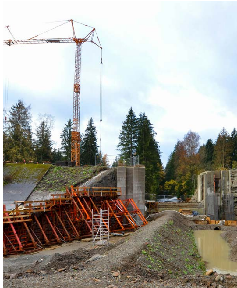
Generalsanierung des Unterwasserbeckens der Sösetalsperre; Umwelttechnik & Wasserbau GmbH, Blankenburg/Harz
