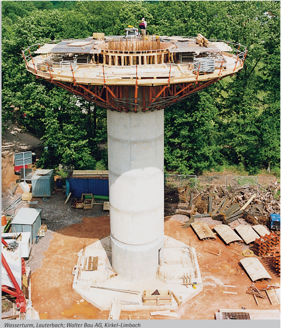
Wasserturm, Lauterbach; Walter Bau AG, Kirkel-Limbach
