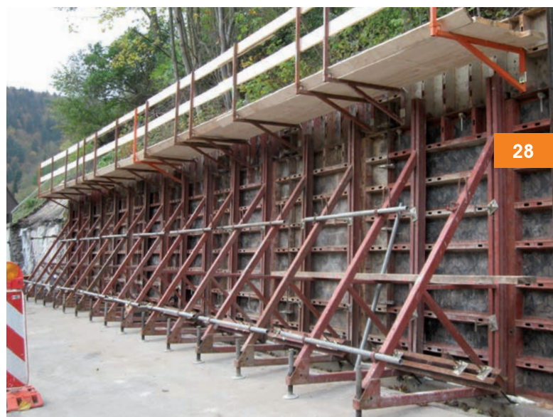
Stützwand, Erneuerung der Ortsdurchfahrt Thale; Umwelttechnik & Wasserbau GmbH, Blankenburg/Harz
