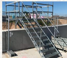
Die Bautreppen können bereits vor dem Transport auf die benötigte Länge vormontiert werden. Die Vor-Ort-Montage ist ohne Aufwand möglich.
